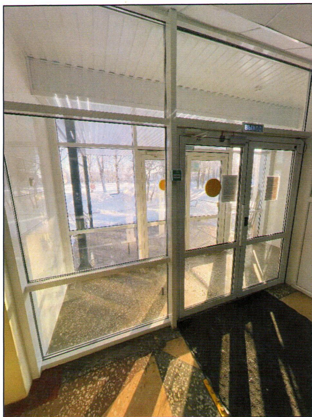
28.Вход в холл
