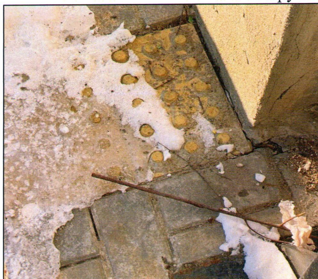
15-16. Тактильный наземный указатель перед пандусом
