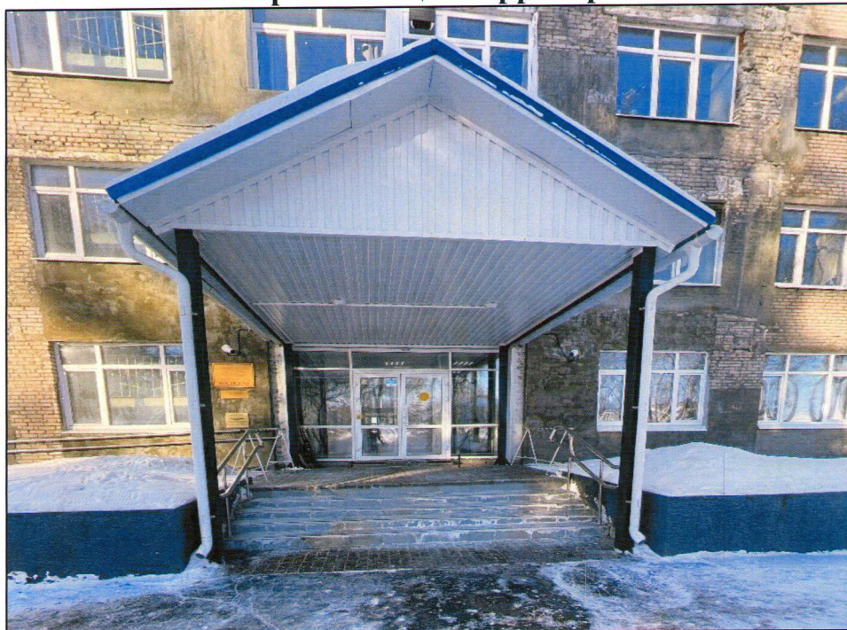
1. Общий вид входа
