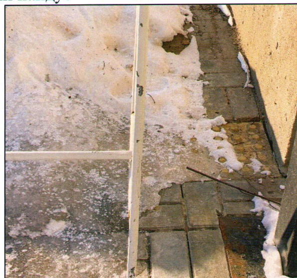
15-16. Тактильный наземный указатель перед пандусом
