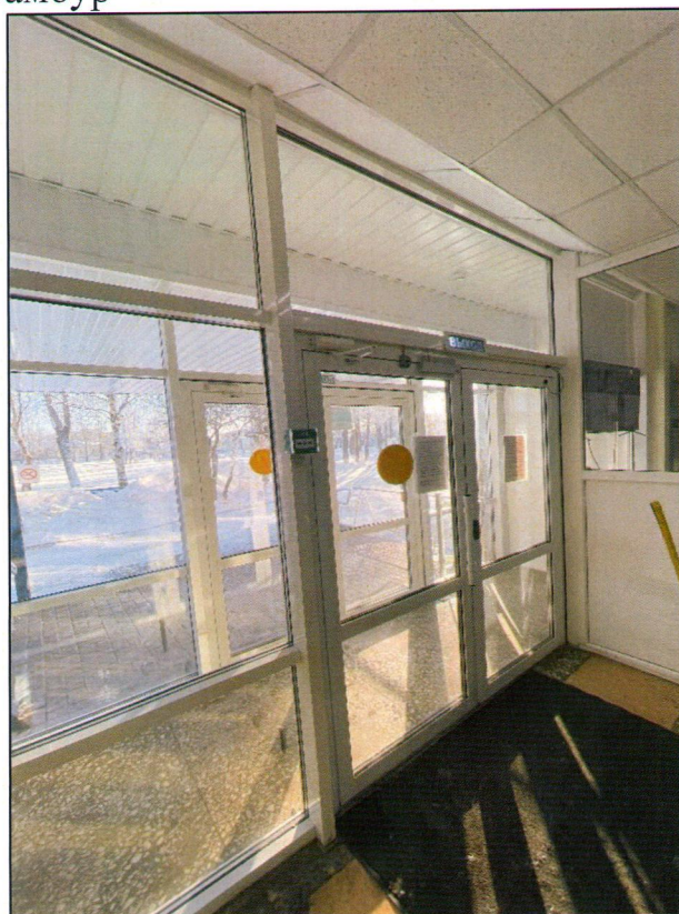
27. Вход в холл
