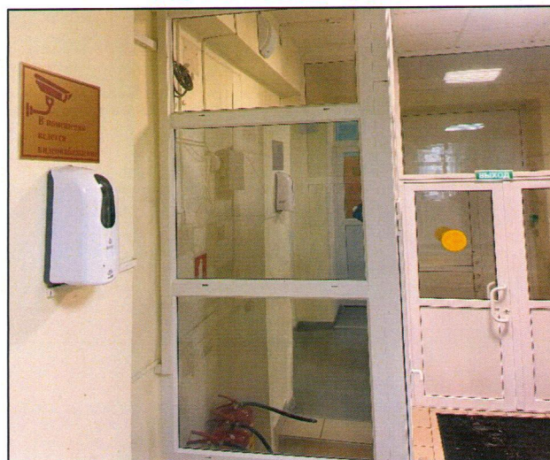
11. Помещение под демонтаж
