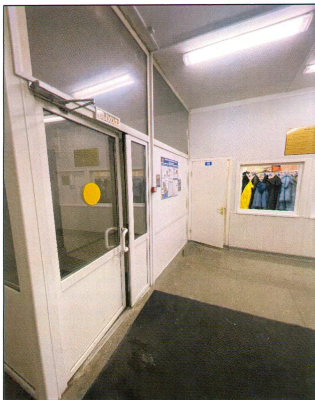
19.Вход в холл
