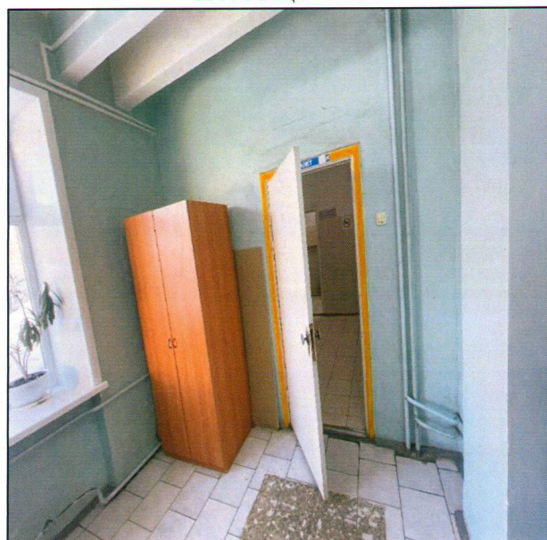
35. Подход к санузелу
