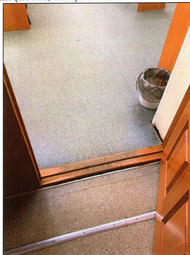
51. Порог входной двери
