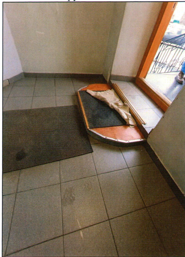
75. Дверной проем и тамбур
